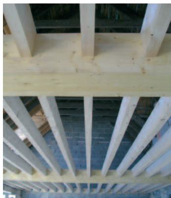
Le plancher de la Conserverie a été assemblé avec des queues d'arronde.
